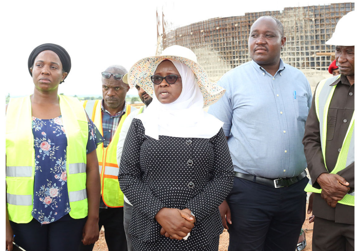
Ziara ya Mkuu wa Mkoa wa Katavi Mhe. Mwanamvua Mrindoko katika mradi wa Maji wa Miji 28 uliopo Kata ya Shanwe Manispaa ya Mpanda.
